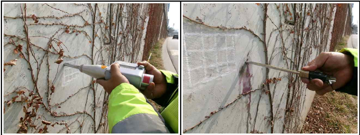
【그림 6.3.8】 콘크리트 내구성 조사 현황
