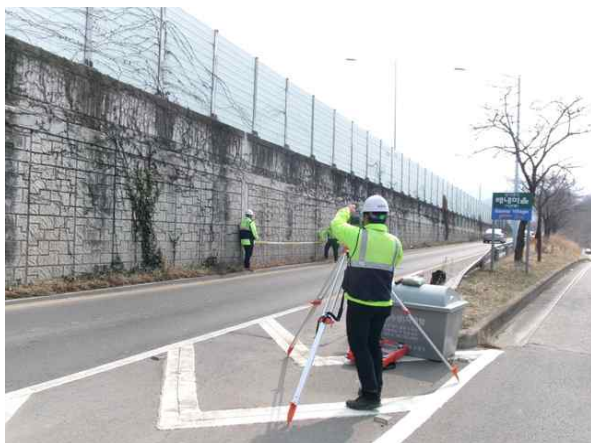
광파기를 이용한 측량 작업
