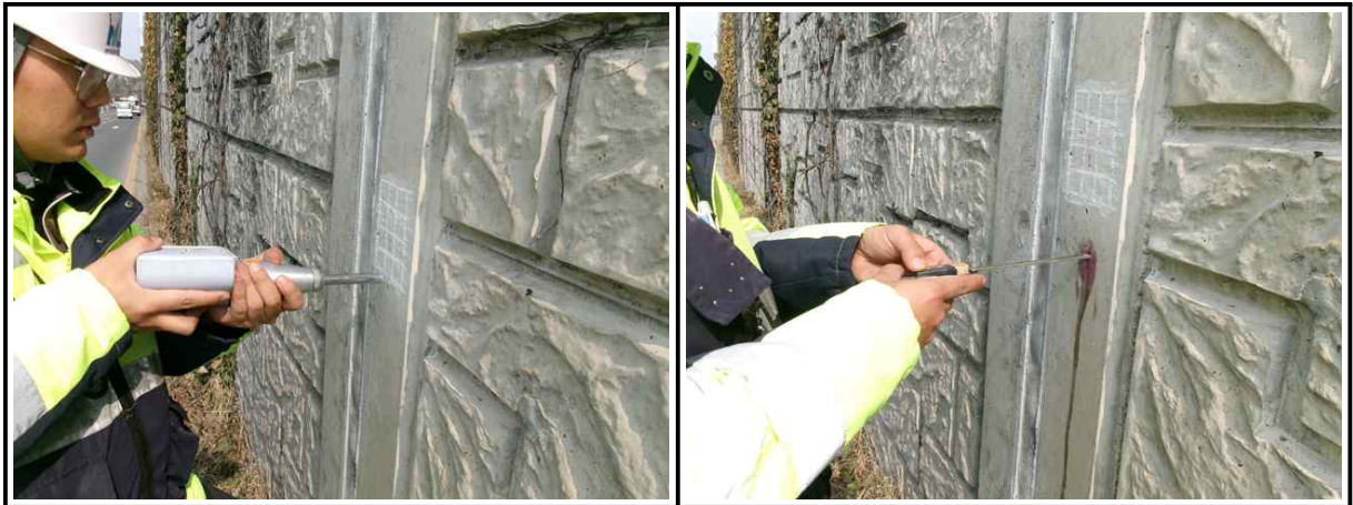
【그림 1.3.6】 콘크리트 내구성 조사 현황
