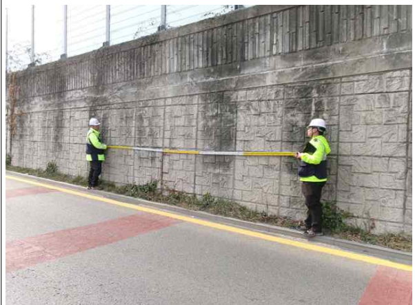
스토퍼를 이용한 구간분할 측정
