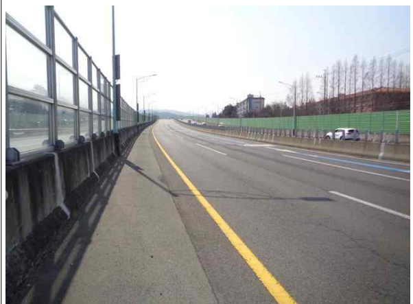
상부 램프도로 전경
