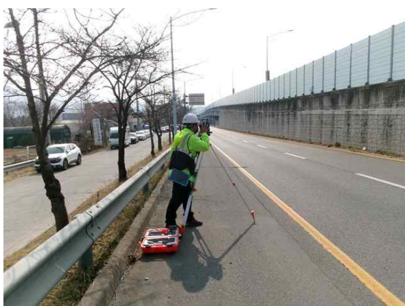
광파기를 이용한 측량 작업
