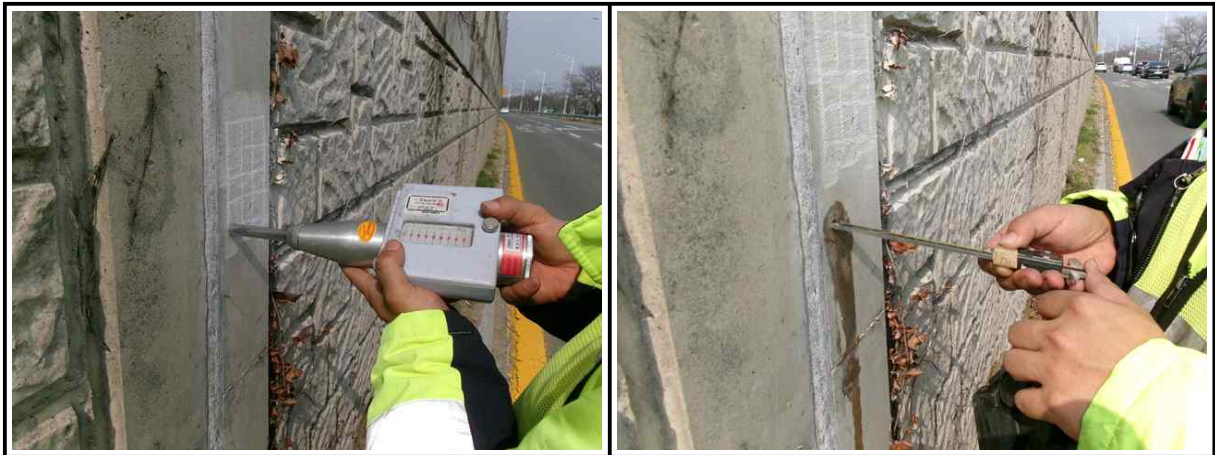
【그림 4.3.7】 콘크리트 내구성 조사 현황
