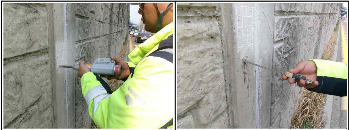
【그림 2.3.6】 콘크리트 내구성 조사 현황
