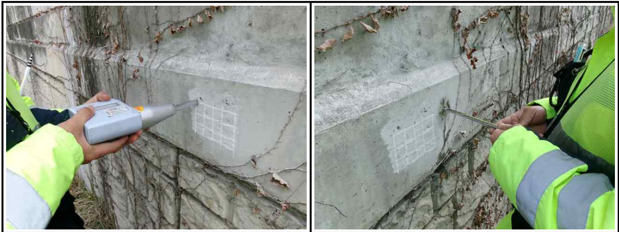
【그림 3.3.7】 콘크리트 내구성 조사 현황
