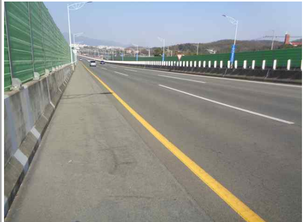
상부 램프도로 전경
