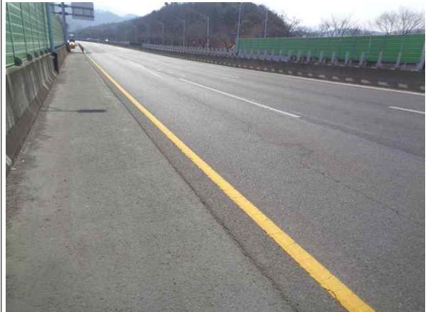
상부 램프도로 전경
