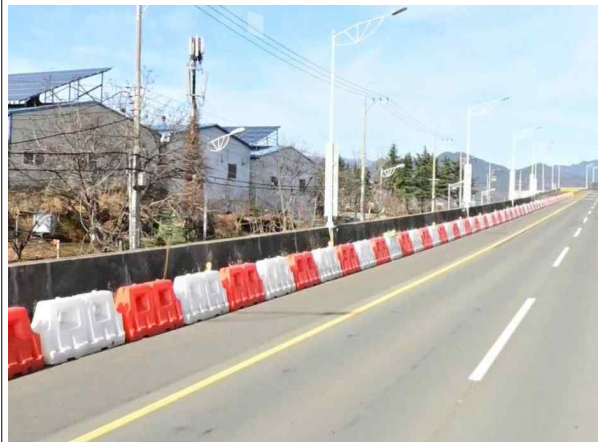
상부 램프도로 전경
