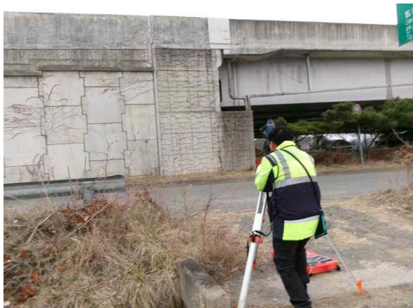
광파기를 이용한 측량 작업
