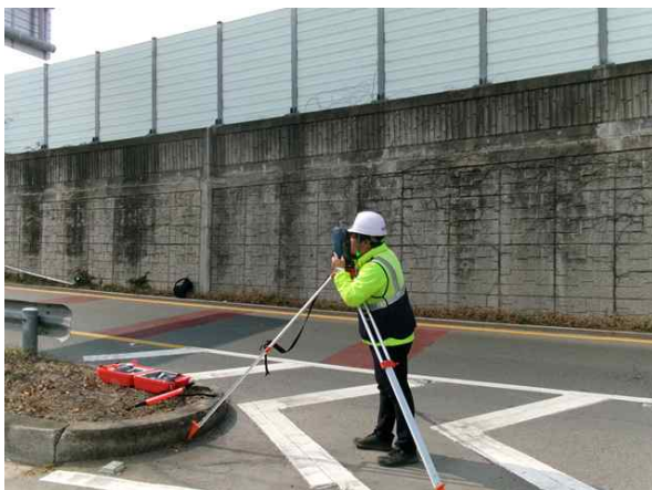
광파기를 이용한 측량 작업
