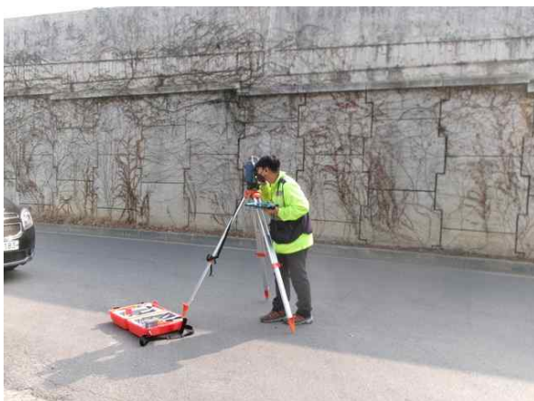
광파기를 이용한 측량 작업
