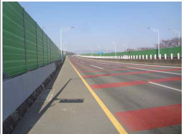
상부 램프도로 전경
