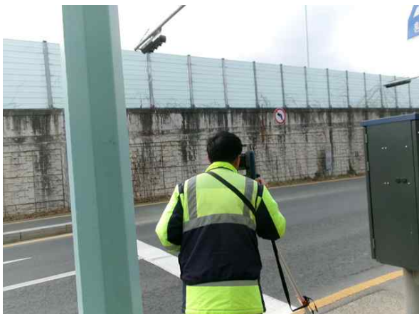
광파기를 이용한 측량 작업
